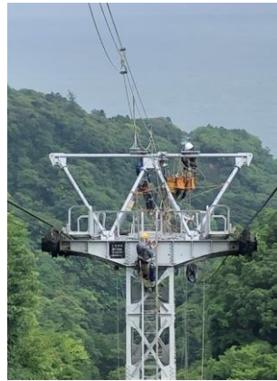
上図左：旧通信ケーブルの撤去と新通信ケーブルの張替え作業の様子
