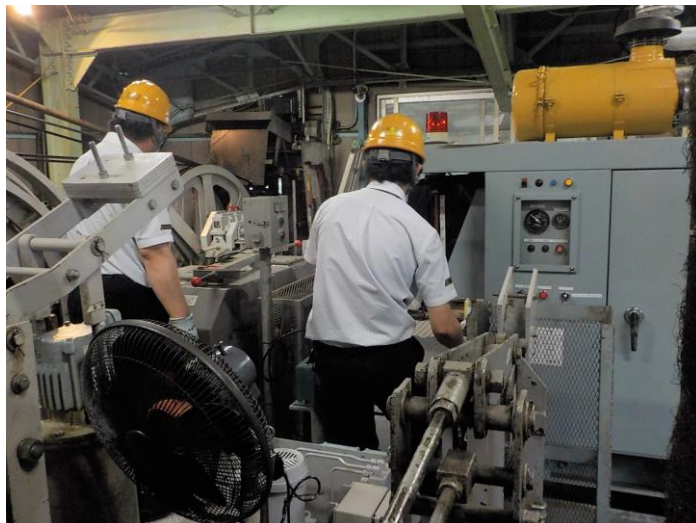
予備原動機の巻き上げを行う様子
