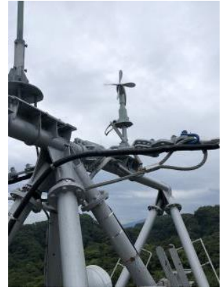
上図左：旧通信ケーブルの撤去と新通信ケーブルの張替え作業の様子
